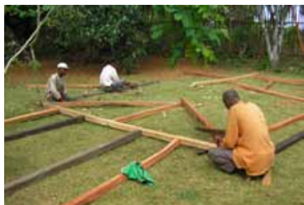
Start på bygging.
